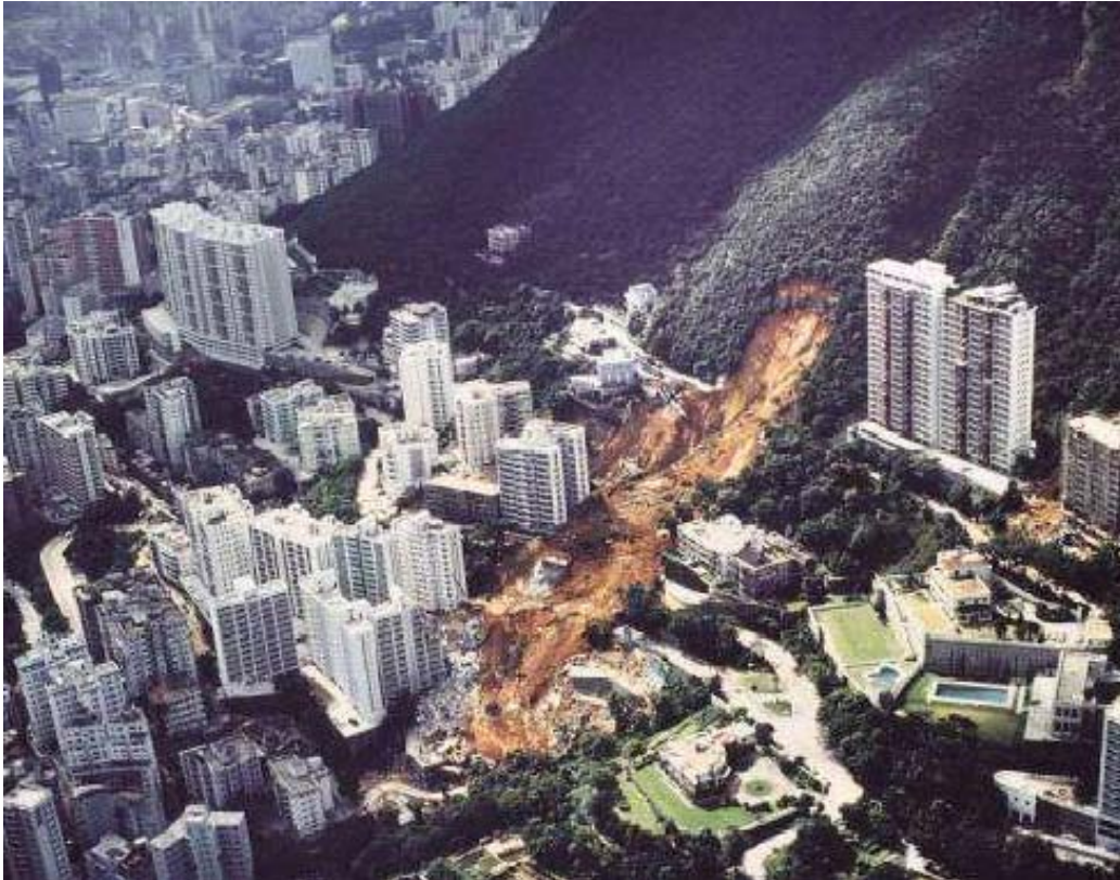
Figura 8 .- Durante un periodo de lluvias continuadas en Hong Kong en el mes de Junio de 1972 ocurrieron en dos deslizamientos importantes: uno en el estado de Kowloon con la rotura de un terraplén de 40 metros de alto que produjo un flujo de tierras que mató a 70 personas y dejó 60 heridos, y otro en Sau Mau Ping (en la foto), flujo deslizante rápido que se llevó por delante un edificio de 12 plantas matando a 67 personas e hiriendo a otras 20.
